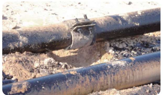
補修パイプライン
