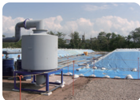
バイオバイル土壌浄化工事
