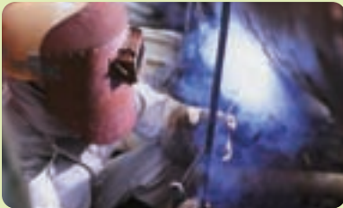
パイプライン建設現場
