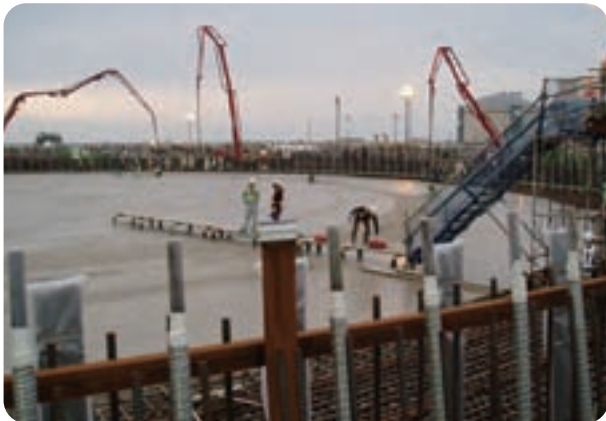
直江津 LNG 受入基地工事現場
