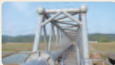
帝石パイプライントラス橋
