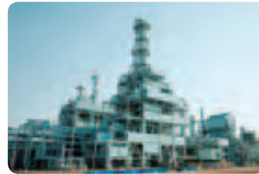
GTL実証プラント
