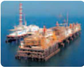
UAE ADMA 鉦区 生産施設
