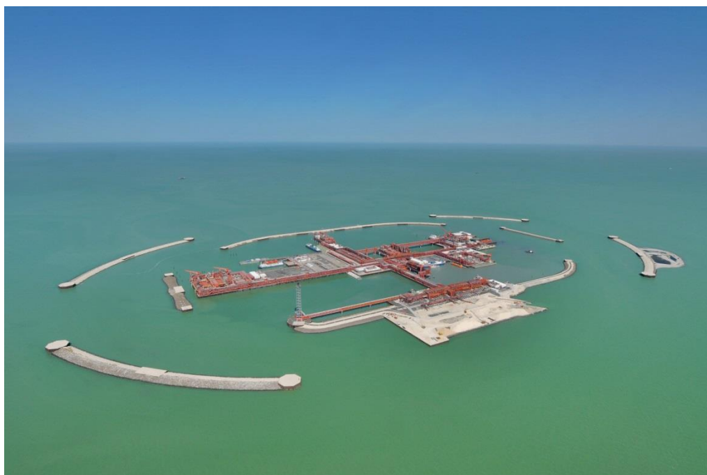
カシャガン油田生産施設
