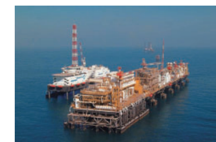
上部ザクム油田生産施設
