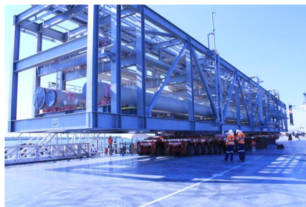
モジュール第一弾の荷揚げの様子 (ダーウィン近郊の LNG プラント現場にて)
