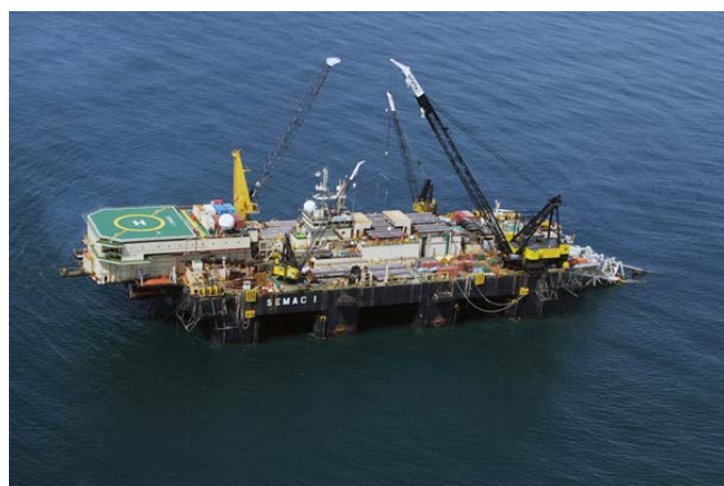
浅海エリアにおける敷設作業船「SEMAC-1」
