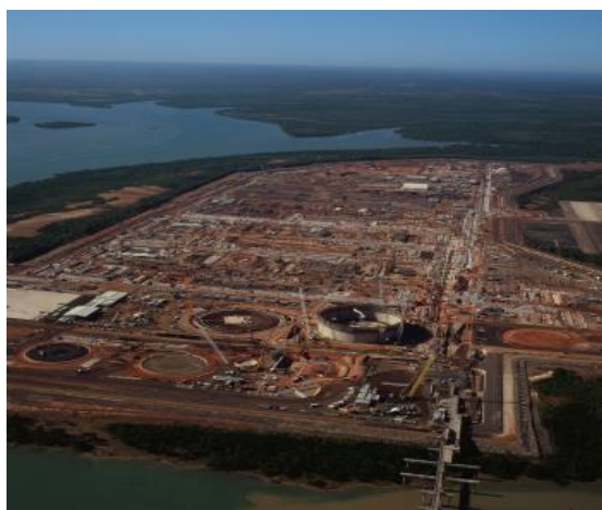
オーストラリア ダーウィンで建設中の 陸上ガス液化プラント
