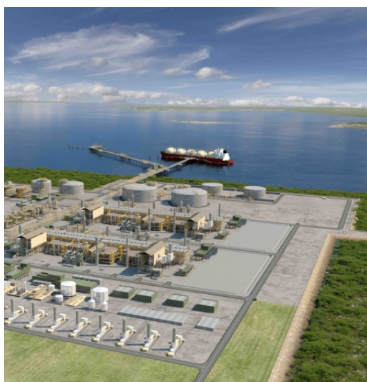
オーストラリア ダーウィンにおけるガス液化プラント建設イメージ図
