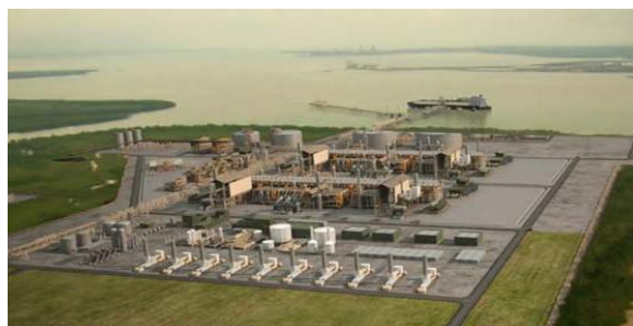
オーストラリア ダーウィンにおける液化天然ガス（LNG）プラント建設イメージ図
