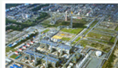
LNG液化プラント
