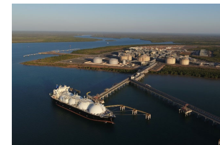
陸上ガス液化プラント （ダーウィン）
