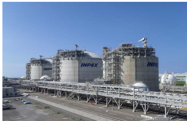
直江津LNG基地
