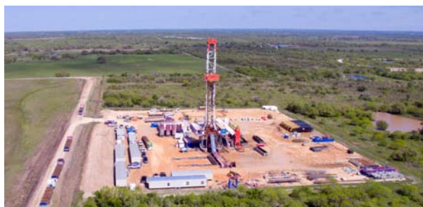
掘削作業現場
