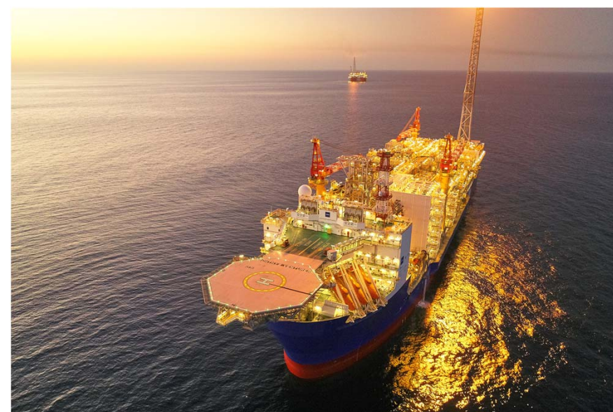
イクシス ガス・コンデンセート田のFPSO
