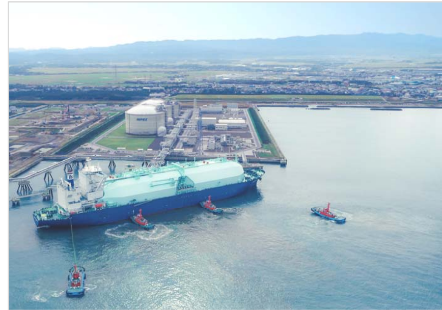
直江津LNG基地
