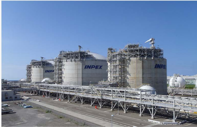
直江津LNG基地
