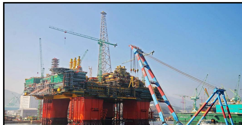
沖合生産・処理施設(CPF)建造の様子(2016年3月)
