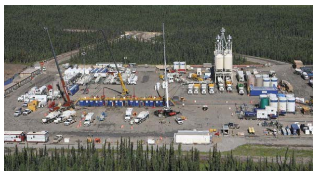
ホーンリバーにおけるフラクチャリング作業現場
