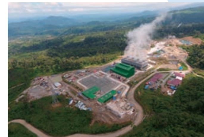
ムアララボ地熱発電所
