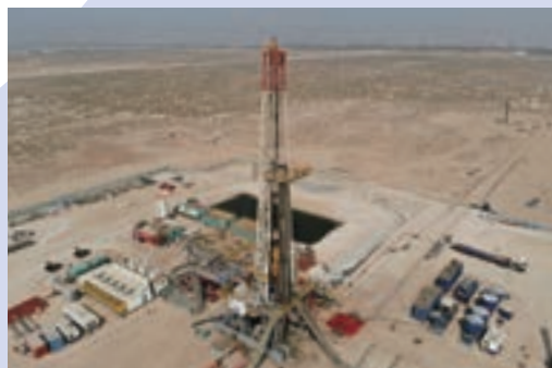
掘削作業の様子
