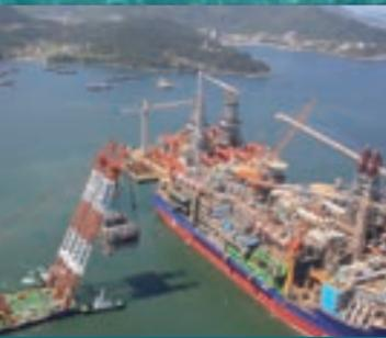
2016年5月 沖合生産・貯油出荷施設(FPSO)の上載設備搭載の完了
