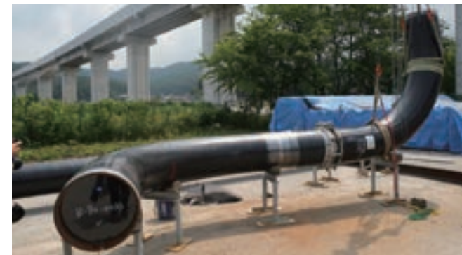
富山ライン建設の様子
