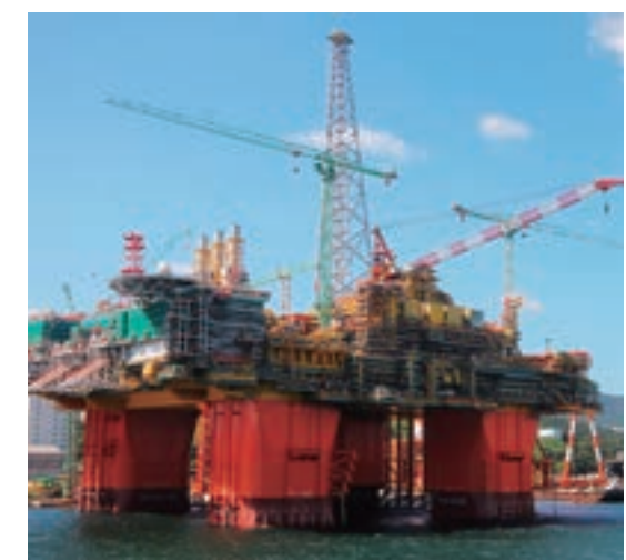
イクシスLNGプロジェクトCPF
