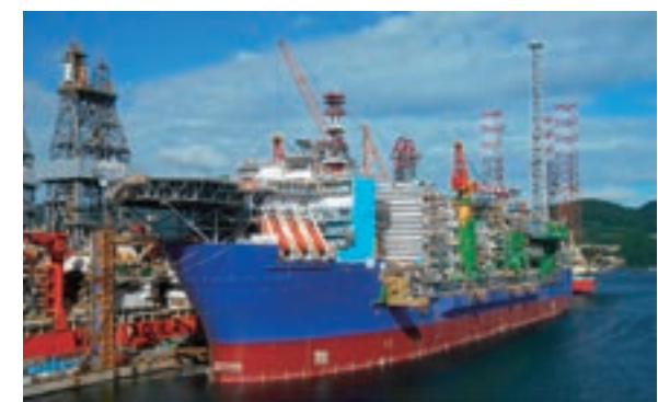
イクシスLNGプロジェクトFPSO
