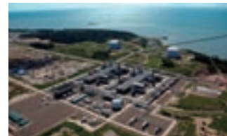
液化プラント既存二系列と LNG タンク、棧橋等
