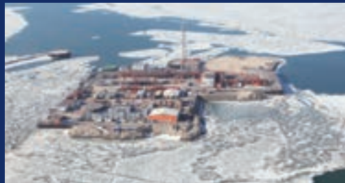
カシャガン油田生産施設の様子
