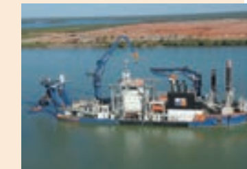
浚渫作業の様子
