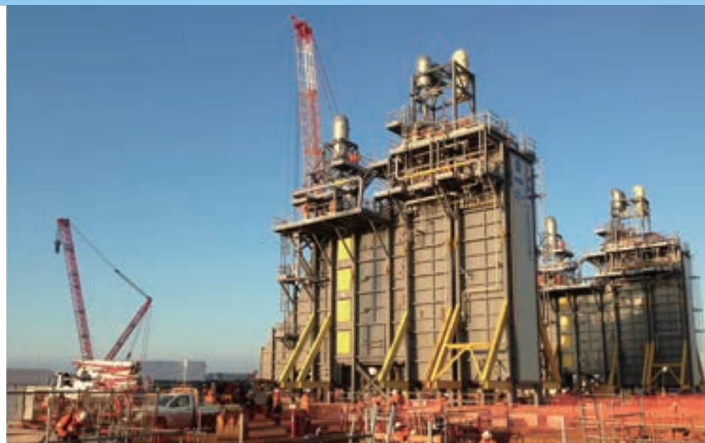
イクシス発電設備建設風景
