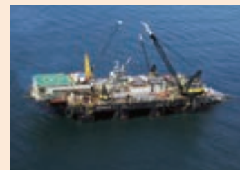
浅海エリアにおける 敷設作業船
