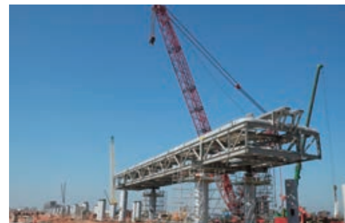
イクシスモジュール据え付け作業風景
