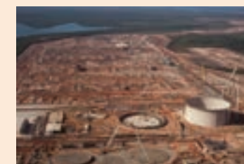
オーストラリアダーウィンで建設中の陸上ガス液化プラント
