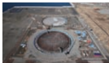
建設工事現場
