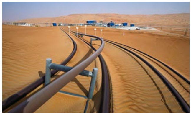
陸上パイプライン
