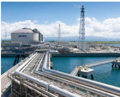
直江津LNG基地
