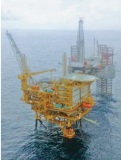
ルビーガス田の洋上生産施設
