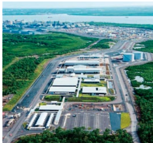
イクシスLNGプロジェクト 陸上ガス液化プラント内にある中央管理施設の外観
