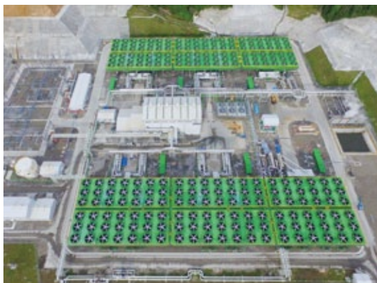
サルーラ地熱発電事業 第1号機の商業運転開始の様子
