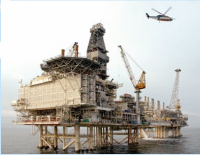
海上生産施設
