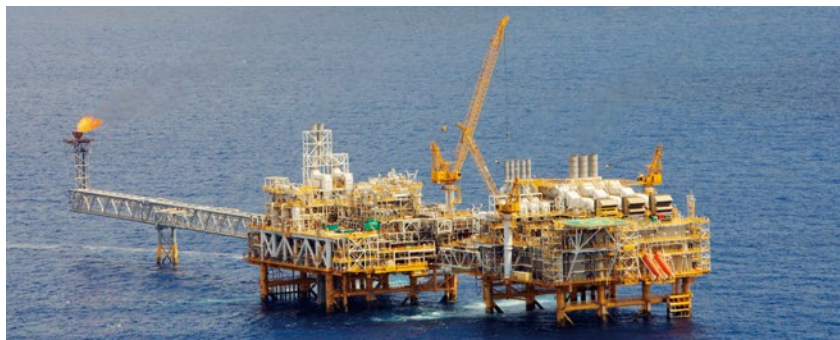
バユ・ウングダン海上生産施設
