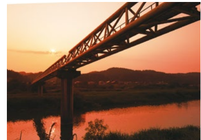
川を渡る天然ガスパイプライン（新潟浪海川）
