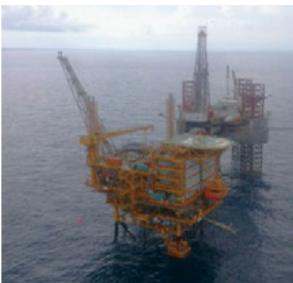
ルビーガス田の洋上生産施設
