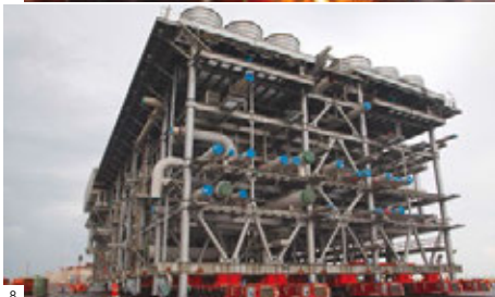
5:ガス・輸送パイプラインの敷設の様子 6:陸上ガス液化プラント建設作業の様子 7:沖合生産・処理施設(CPF)のモジュール据え付け作業の様子 8:陸上ガス液化プラントを構成するモジュールの搬入作業の様子 9:陸上ガス液化プラント全景
