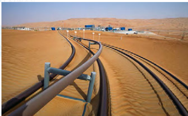
陸上パイプライン
