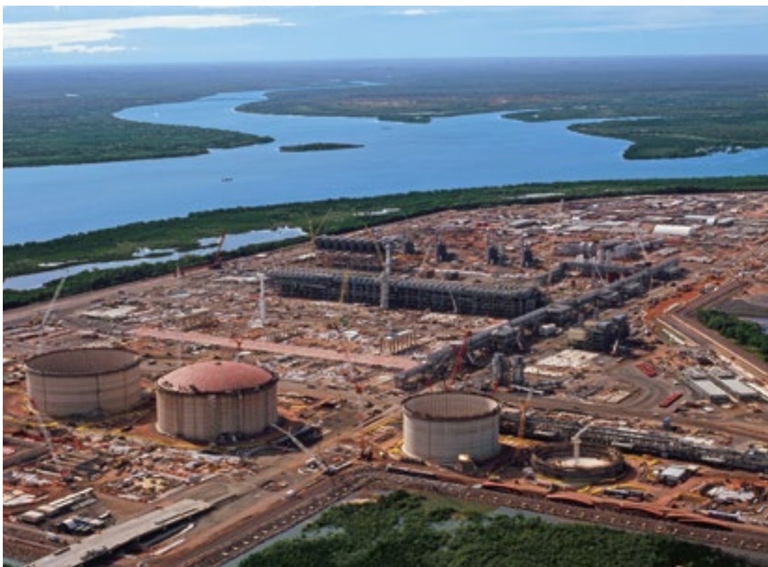
建設が進む陸上ガス液化プラント
