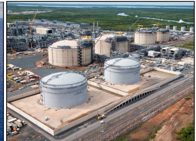
陸上施設タンクエリア
