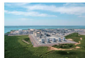
Ichthys Onshore LNG Plant
