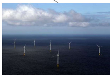
Luchterduinen offshore wind farm
