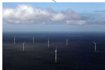
Luchterduinen offshore wind farm
