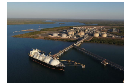
Onshore LNG Plant (Darwin, Australia)
