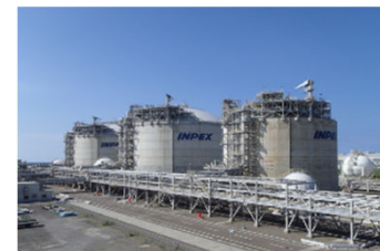
Naoetsu LNG Terminal (Niigata, Japan)
