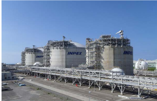
Naoetsu LNG Terminal
