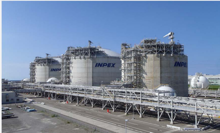
Naoetsu LNG Terminal
