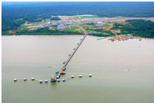
Tangguh LNG Plant
