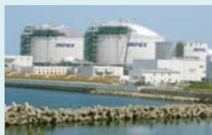
Full view of the Naoetsu LNG Terminal
