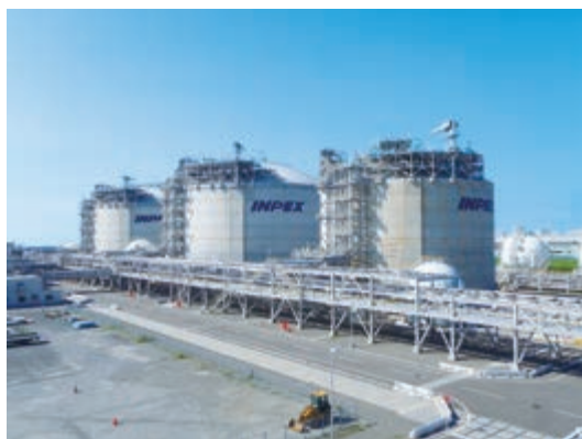
直江津LNG基地
