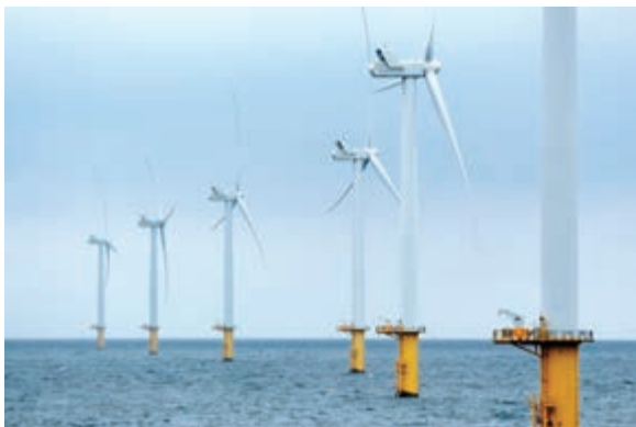
ルフタダウネン洋上風力発電
