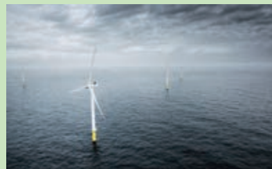
ルフタダウネン洋上風力発電
