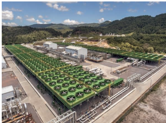
サーラ地熱発電事業3号機
