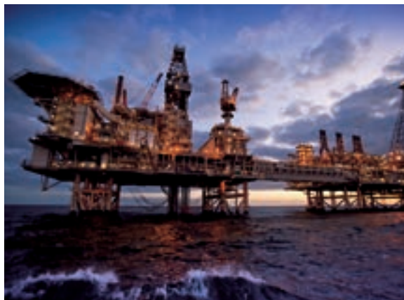
ACG油田の海上生産施設
