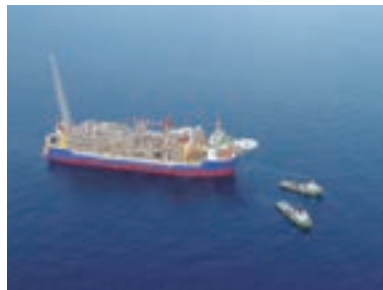
沖合生産・貯油出荷施設(FPSO)
