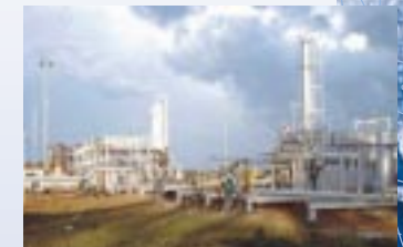
ベネズエラ石油：ガス処理プラント
