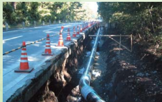
建設中の静岡ライン
