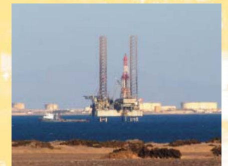
海洋掘削装置(KEZ鉱区)
