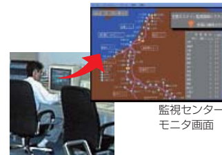
監視センター
