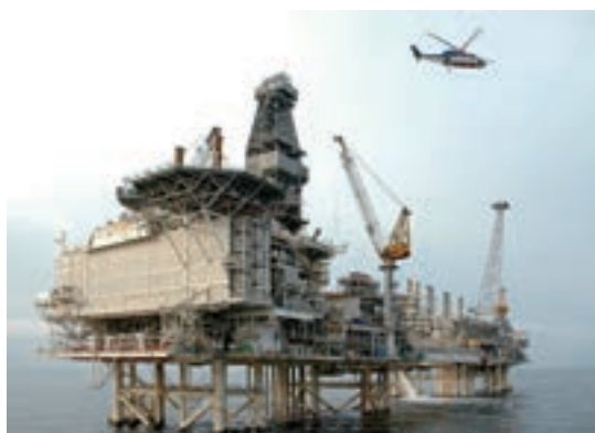
海上生産施設
