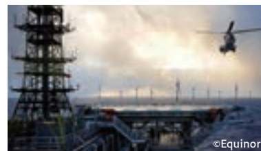
生産施設から望むハイウインド・タンベン(完成予想図)
