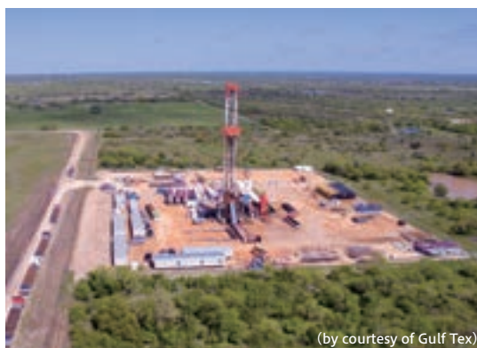
掘削作業現場
