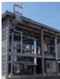
越路原プラント内の実証設備
