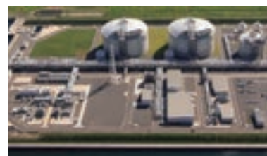
直江津LNG基地
