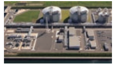
直江津LNG基地
