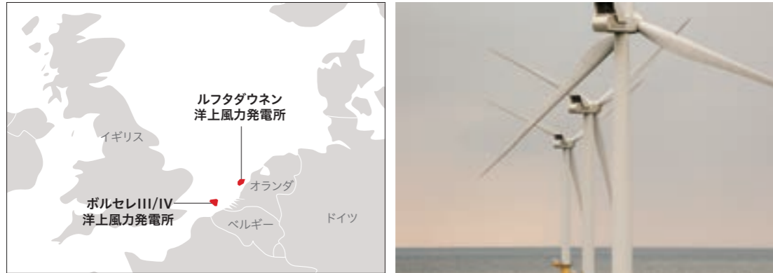
ルフタダウネン洋上風力発電所
