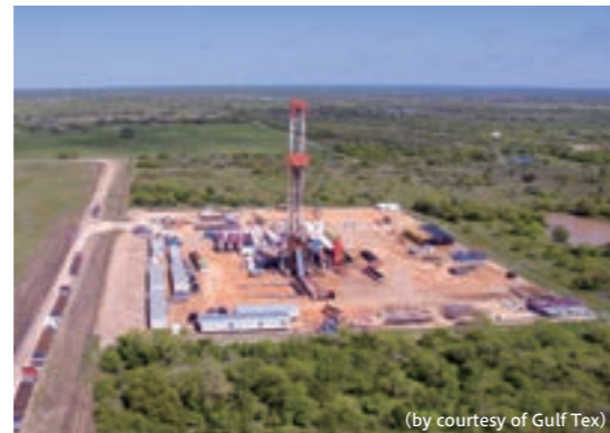
掘削作業現場
