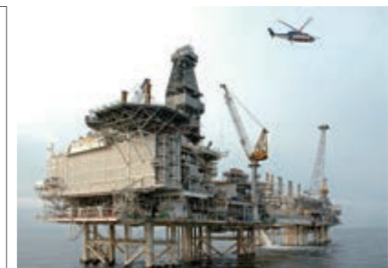
海上生産施設
