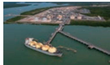
イクシス陸上ガス液化プラント
