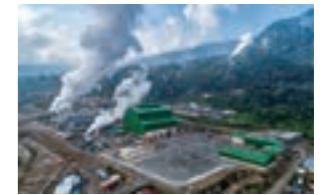
ムアラボ地熱発電所
