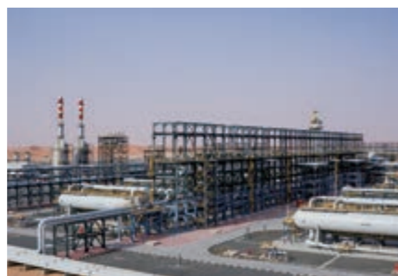
アブダビ陸上鉱区(原油処理施設)
