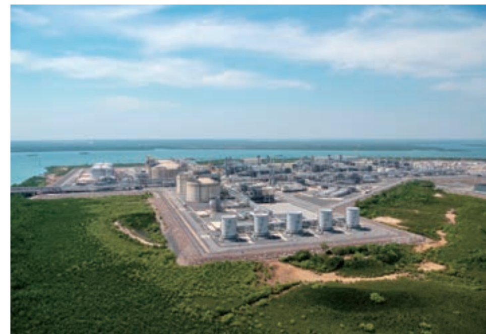
イクシスLNGプロジェクト 陸上ガス液化プラント
