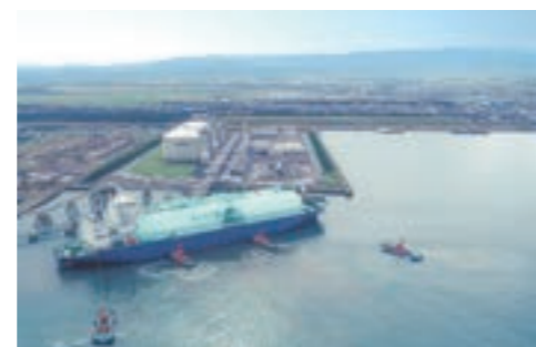
直江津LNG基地
