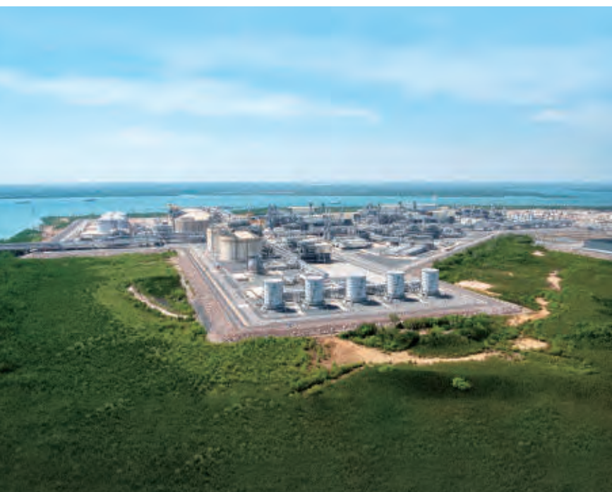
イクシスLNGプロジェクト ダーウィンの陸上ガス液化プラント
