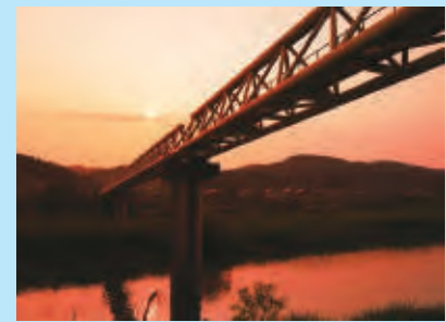
川を渡る天然ガスパイプライン(新潟県澁海川)
