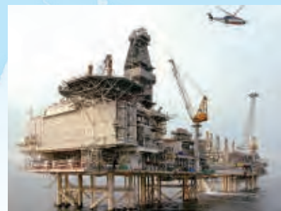
海上生産施設
