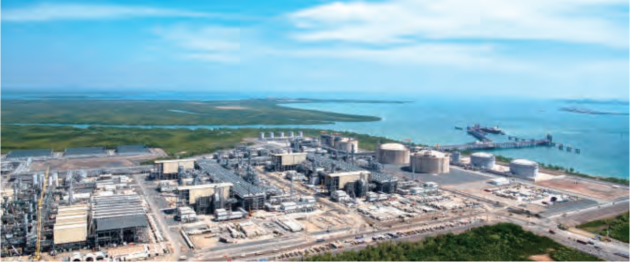
陸上ガス液化プラント
