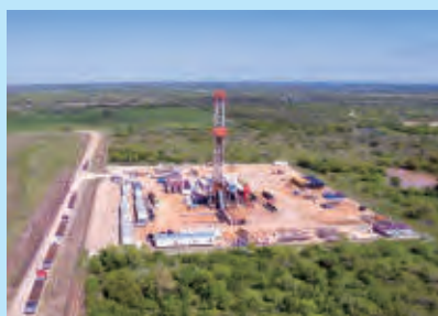
掘削作業現場
