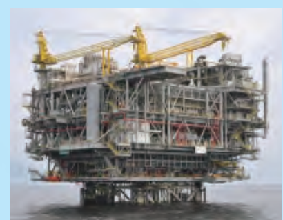
海上生産施設
