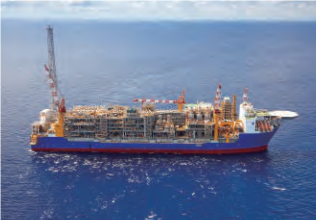
FPSO「イクシス ベンチャラー」
