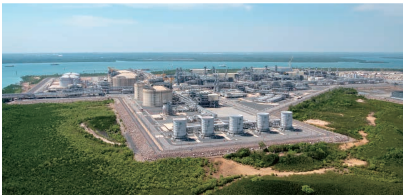
イクシスLNGプロジェクト 陸上ガス液化プラント
