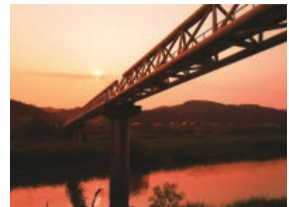
川を渡る天然ガスパイプライン(新潟県渡海川)
