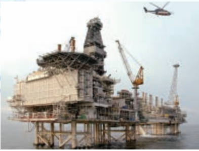
海上生産施設
