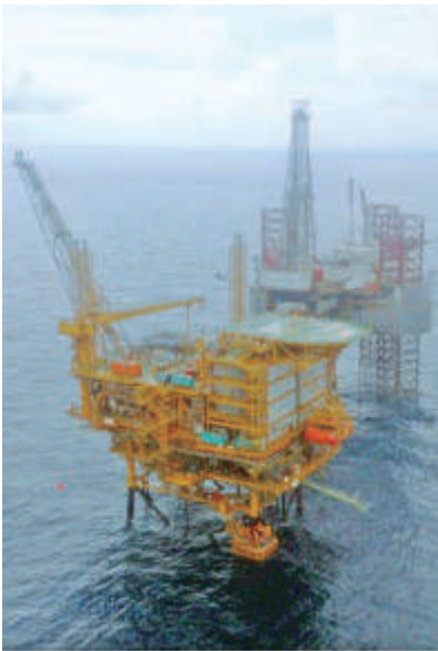
ルビーガス田の洋上生産施設
