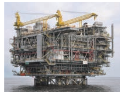
海上生産施設
