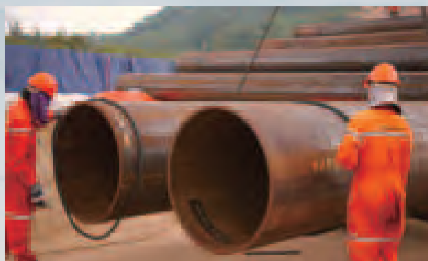
(左)(右)パイプライン用鋼管の荷下ろし作業 コーティング作業のために運ばれた鋼管をマレーシアのクアンタンで荷下ろしする様子。ドイツと日本で製造したパイプライン用鋼管は、インドネシアとマレーシアでコーティング作業が行われています。
