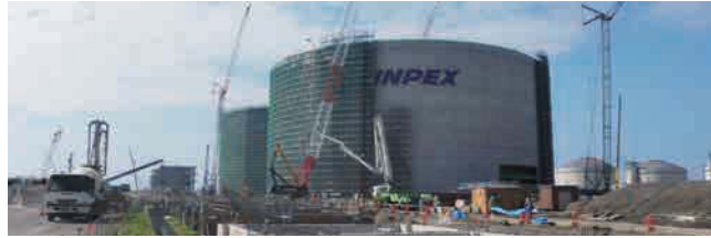
直江津LNG受入基地の工事風景
