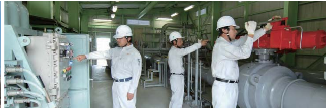
バルブステーション漏洩調査
