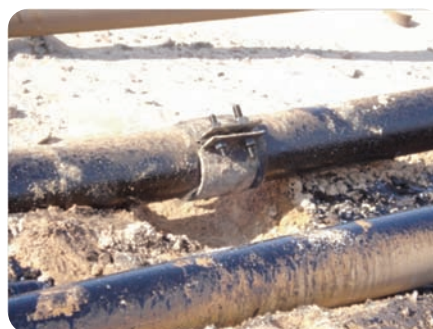
補修パイプライン
