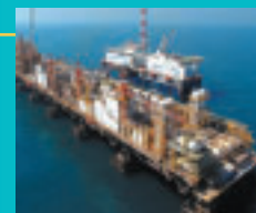
アブダビ沖ADMA鉱区 生産処理施設
