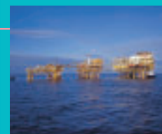
東カリマンタン沖アタカユニット 生産処理施設
