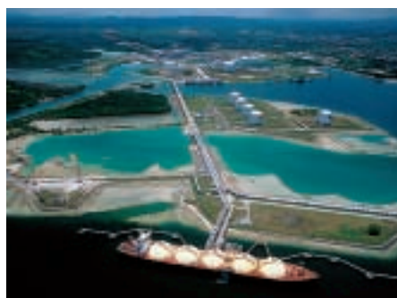
ボンタンLNG基地
