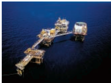
アタカユニット生産処理施設
